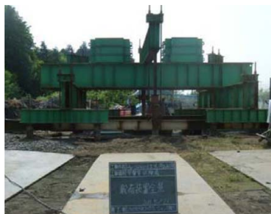
写真 1 載荷試験の装置
