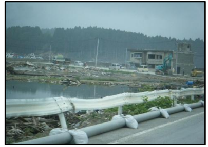
ガードレール下は仮設水道管
