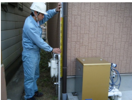
写真 5 沈下計測状況
