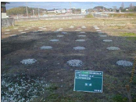
写真 3 施工後の状況
