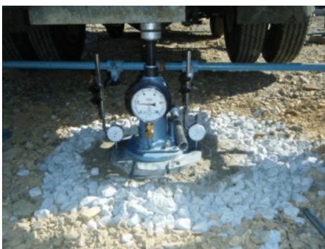
写真 4 平板載荷重試験状況
