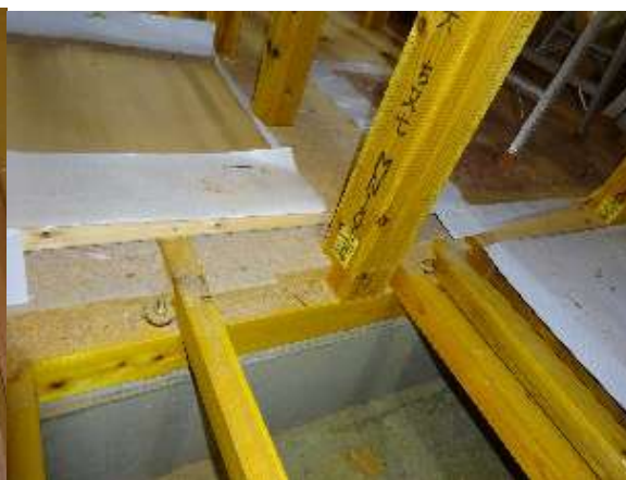
軸組、根太工法の UFO-E ナット
