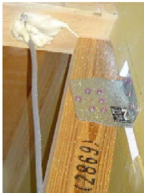
基礎廻りは異常なし
