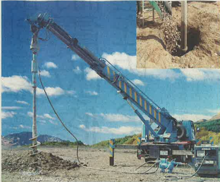
▲建柱車で地面に穴を開け、天然砕石を詰め込む(右上)
