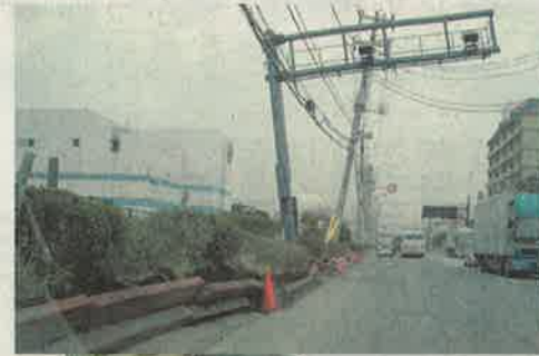
◀東日本大震災で被災した千葉県浦安市(資料) ▼東日本大震災で液状化現象が起こった茨城県潮来市の住宅街(資料)
