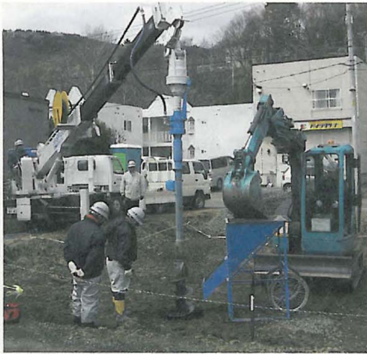
建柱車を改造した作業車(写真左奥)で、20~40mmの天然砕石(写真右の青い部分から)を注入していく
