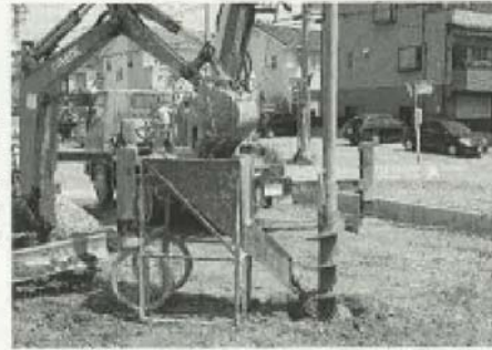
砕石パイルの施工風景
