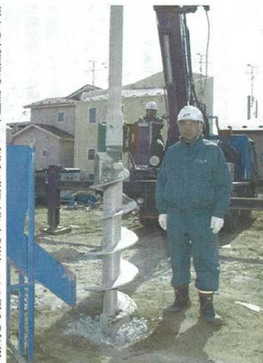
天然砕石による地盤改良工法を利用し事業展開する沼栄工業の沼端一彦社長
