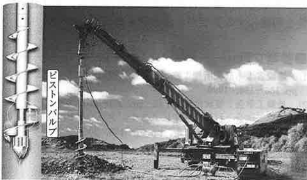
写真-1 改良機施工状況
