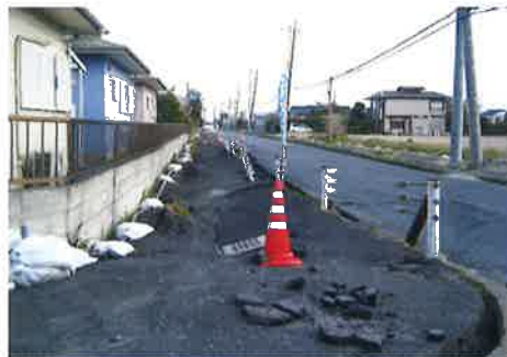
東日本大震災で首都圏において大きな被害をもたらしたのは「液状化」。沿岸の埋め立て地だけでなく内陸部でも数多く発生し、住宅地に被害がでた
