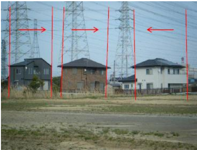
液状化によって建物の不同沈下が起こっている。 荷重の掛かり方と、噴砂の多さによって沈下の方向 沈下の量に差がある
