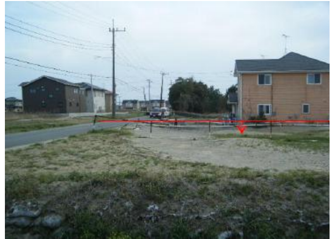
全体的に地盤が下がり建物が沈下している。
